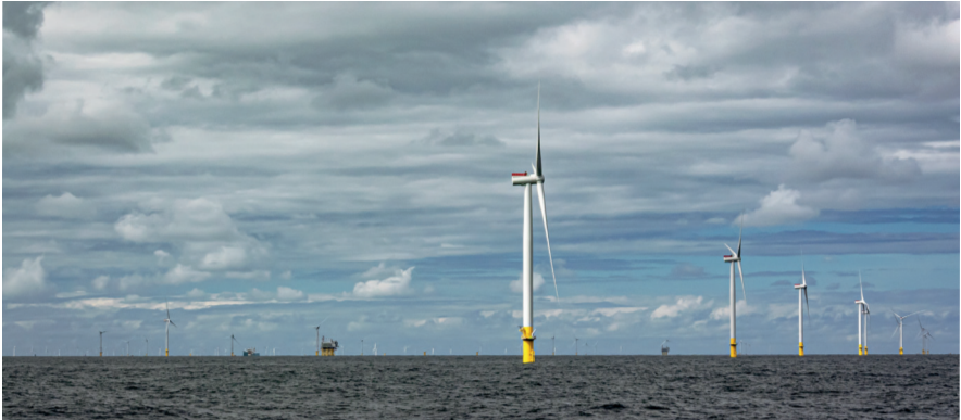
Windpark Borssele met aan de horizon transformatorplatforms Borssele Alpha en Beta.
